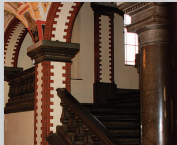
Treppenbalustraden und Säulen aus Raerener Blaustein
