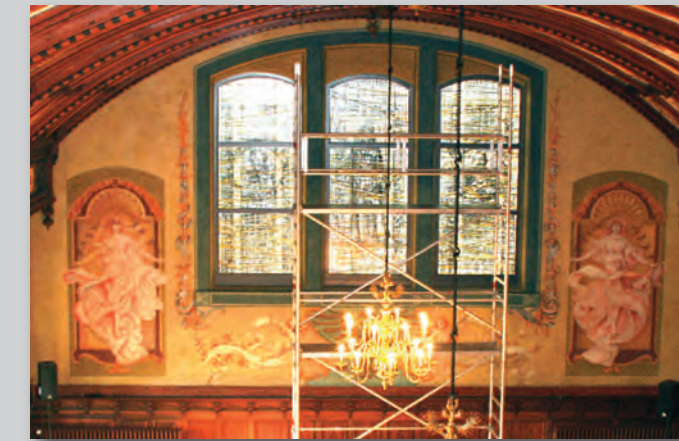
Einbau der neuen "Kaiserfenster" am 30. Oktober 2012
